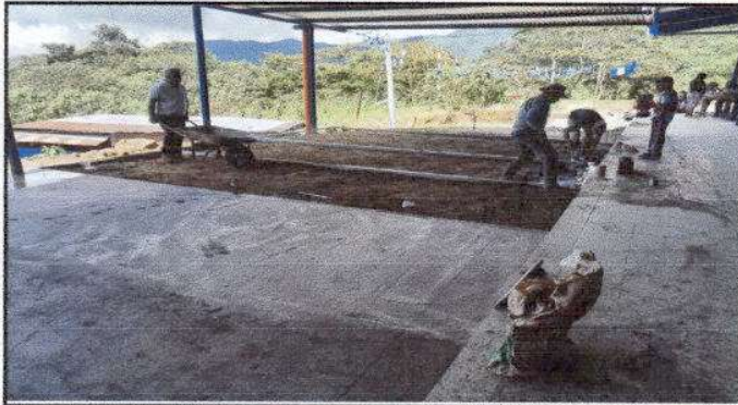
Foto1: Sustitución de piso de torta de concreto
