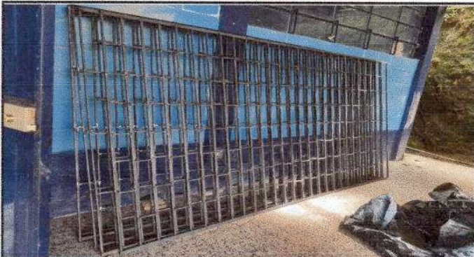
Foto 3: Fabricación e instalación de ventana-balcon de metal
