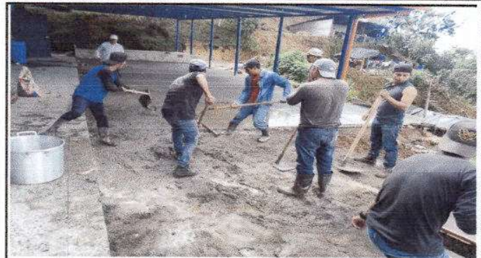
Foto 2: Sustitución de piso de torta de concreto
